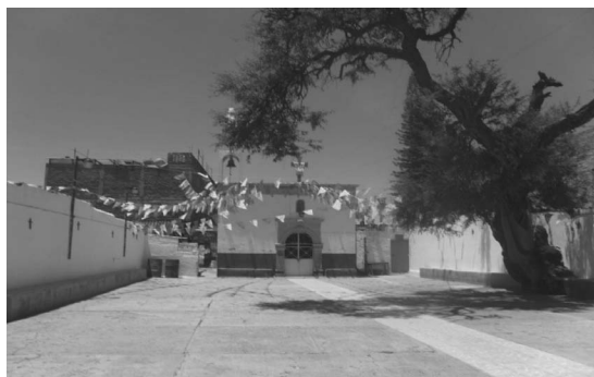
FACHADA Y ATRIO DE LA CAPILLA DE LA SANTA CRUZ DE CULIACÁN
