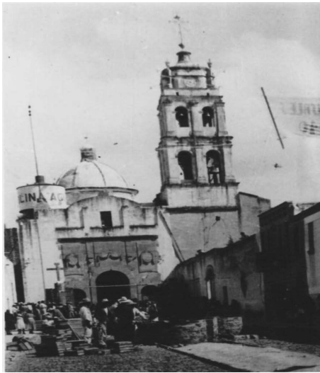
COLOCACIÓN DEL PISO EN EL ATRIO DEL TEMPLO DEL SEÑOR DE SAN JOSÉ, PATRONO DE LA CIUDAD DE CORTAZAR, GTO. 1939-1940. FOTO M. REYES
