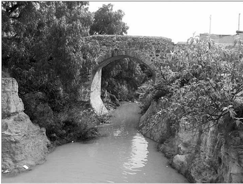
PUENTE “LA OTRA BANDA”
