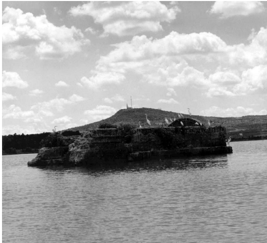
Presa El Palote. León, Gto.
