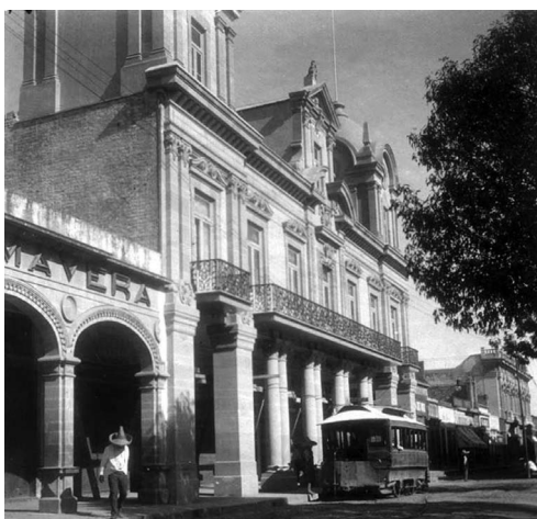
Edificio del Portal Aldama
