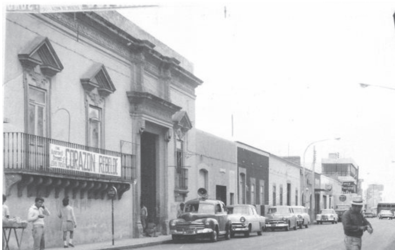
CASA MONUMENTAL. UN NOTABLE EJEMPLO DEL NEOCLÁSICO DEL SIGLO XIX. DESARROLLADA EN UNA PLANTA, PERO CON UN SEMISÓTANO AL CUAL SE DEBE SU GRAN ALTURA
