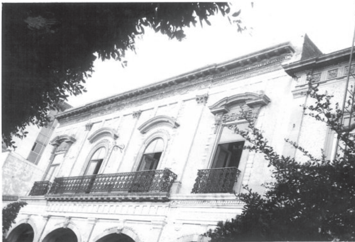
CASA EN PORTAL JOSE ROJAS GARCIDUEÑAS. ESTA CASA ES NOTABLE POR TENER SU FACHADA DE PLANTA BAJA EN ESTILO BARROCO, INTERIORES Y PORTADA DE PLANTA ALTA CON ELEMENTOS NEOCLÁSICOS Y PRIMER PATIO CON ARCOS NEOGÓTICOS
